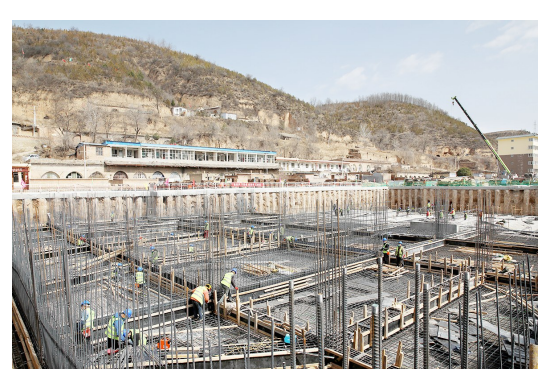
3月16日,在泥湾湾红色文化小镇项目大生产纪念馆工地,160余名施工人员正在抓紧施工。作为延安第一批复工复产的红色文化项目,该项目部经过多方努力,协调解决了当前人员和材料短缺问题,现已全面展开施工作业。 刘祥胜 摄
