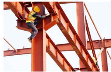
3月24日，渭南市南京金龙纯电动商用车项目车架联合厂房工程施工现场，工人师傅在高空安装网架、喷涂油漆。连日来，位于渭南经开区中部工业区的省级重点项目——南京金龙纯电动商用车项目施工现场，工人们每天攀上高空进行作业，成为建设工地上的“蜘蛛人”。 □崔正博 摄
