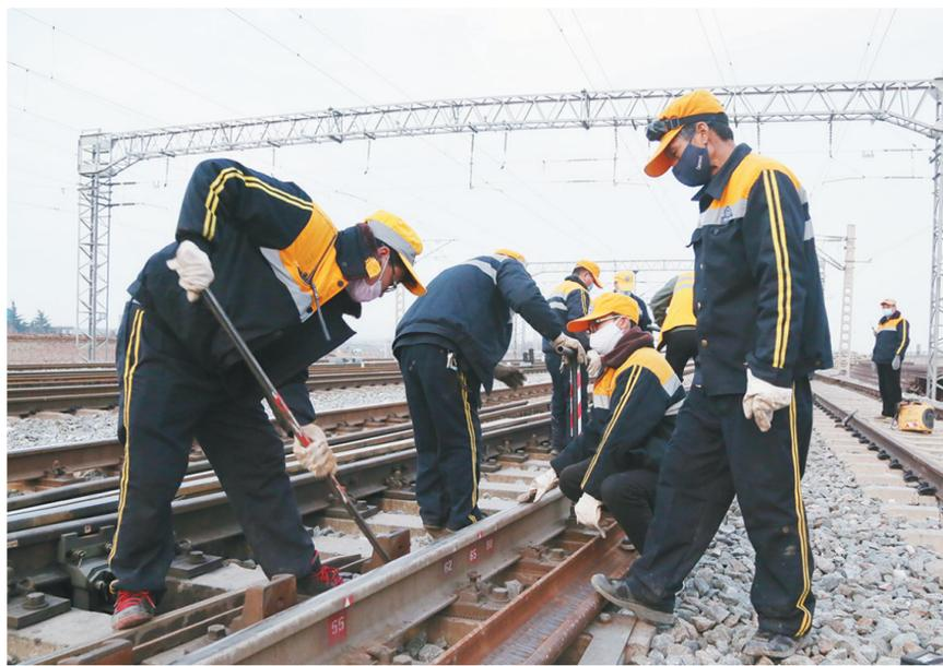
连日来,中国铁路西安局集团有限公司延安工务段针对管内包西线岔区不良钢轨、路基惯性下沉、翻浆冒泥等重点病害,详细制定施工方案,加强设备整治,全力保障管内行车安全。图为3月28日,该段职工在管内包西线甘泉北站内进行道岔病害整治作业。 □李晓龙 摄
