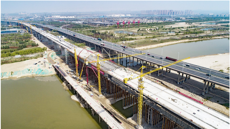
4月6日,西银高铁重点控制性工程——咸阳渭河特大桥施工现场。袁景智 摄
