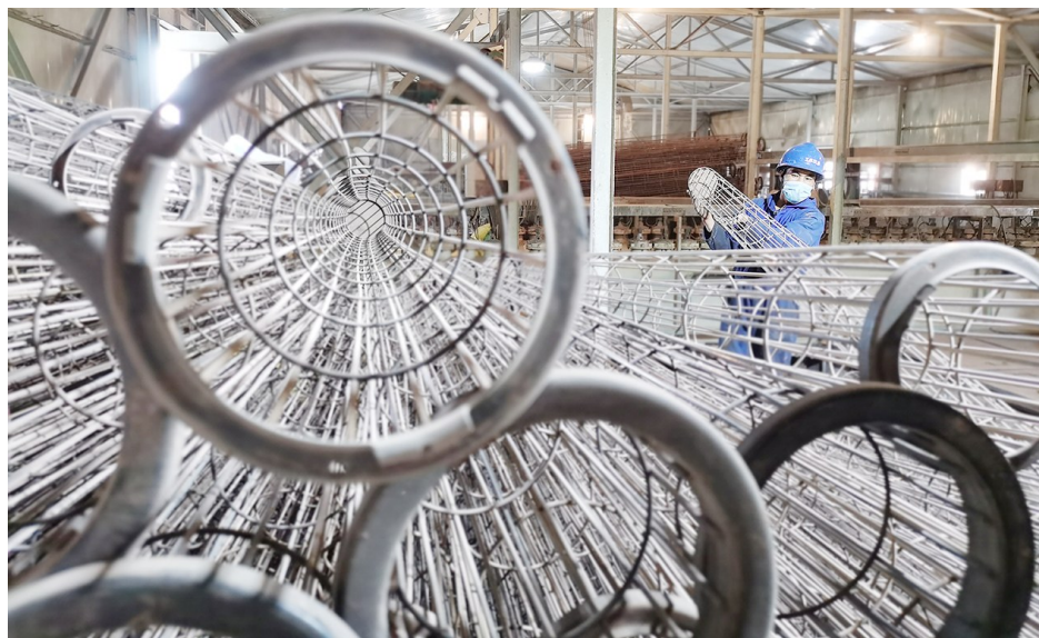
5月1日,陕西华电瑶池发电有限公司检修人员检查除尘器布袋护罩使用情况,确保企业、市民假期用电需求。席战宁 孙俊峰 摄
