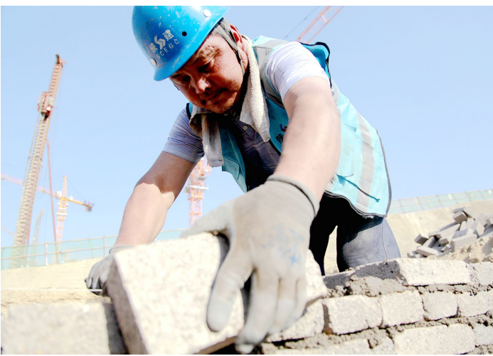
5月1日,在陕建八建集团新筑新城二期安置房项目施工现场,建设者加紧施工,确保按节点完成目标任务。 陈玺龙 摄
