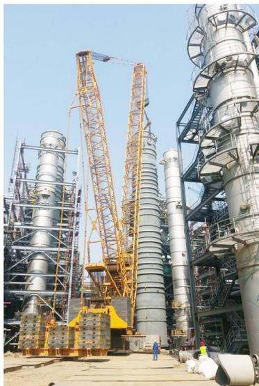
5月6日,陕西化建吊运公司完成大连恒力石化PTA-5装置重110吨的氧化反应器搅拌机设备吊装。至此,大连恒力石化PTA-4/5项目所有大中型设备吊装工作全面完成。 陈练斌 摄
