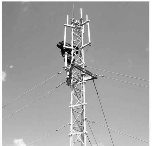
近日,陕西长安电力榆林配售电有限公司50MW分散式风电项目测风塔安装工程顺利完成。据悉,该测风塔采用桁架式结构,塔高120米,位于海拔1230米的榆林市府谷县清水镇,具有风场数据代表性,为新型能源项目在陕北部署。李智强 张智泉 摄
