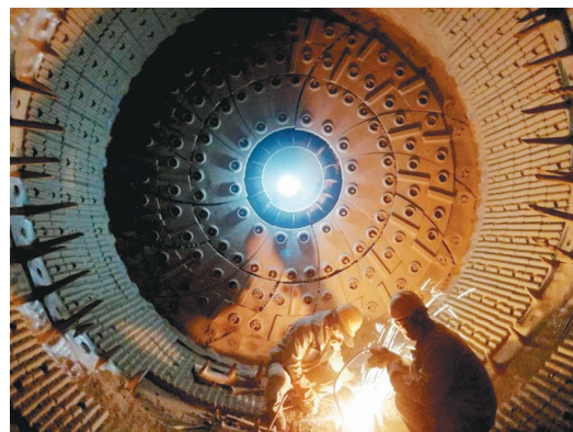
5月12日,陕西省宝鸡凤凰山海螺水泥有限公司水泥厂职工正在更换水泥磨内衬板。该公司自2月20日复工复产以来,坚持防疫疫情、拓市场、严管理、增效益,1至4月份生产经营创历史同期最优水平。□王红敏 张磊 摄
