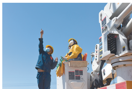
近日,国网长安区供电公司提前16天完成业扩配套西安市大美林庄农业种植专业合作社10千伏电源点新建工程。该项工程新建的高压线路和配变将为该区域进一步探索“整、稻、鱼共生”的新型农业产业发展模式创造了可能。□冯星源 周爽 摄
