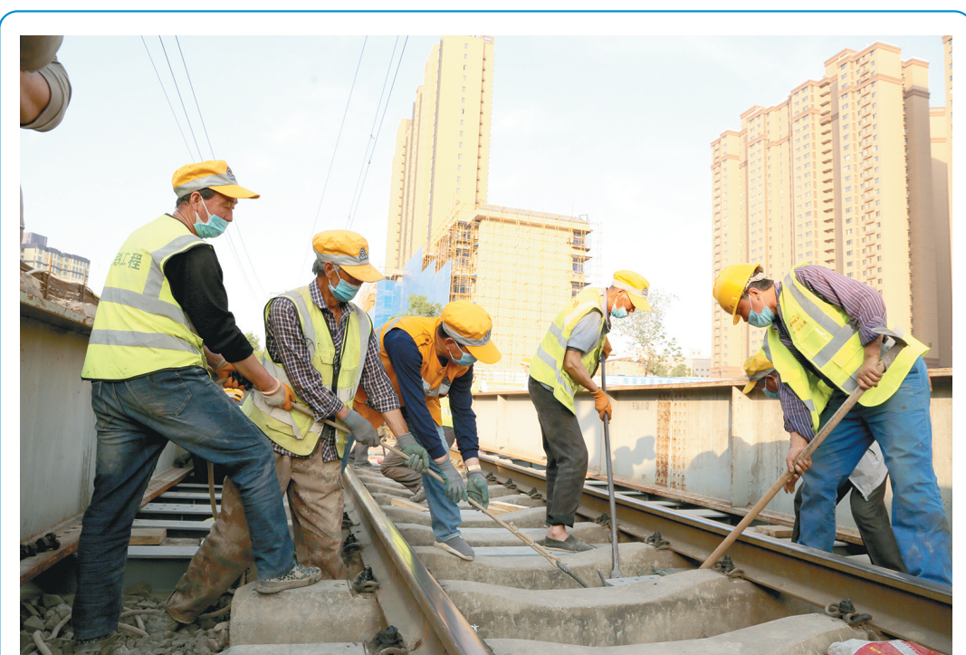
针对高温下户外作业特点,中国铁路西安局集团有限公司西铁工程公司进一步强化人身安全案例教育,积极排查整治职工人身安全隐患。图为5月29日,在该公司承建的西安市经九路下穿陇海铁路施工现场,参建职工正在管理人员的监控下进行铁路架空施工作业。 □田家卫 摄
