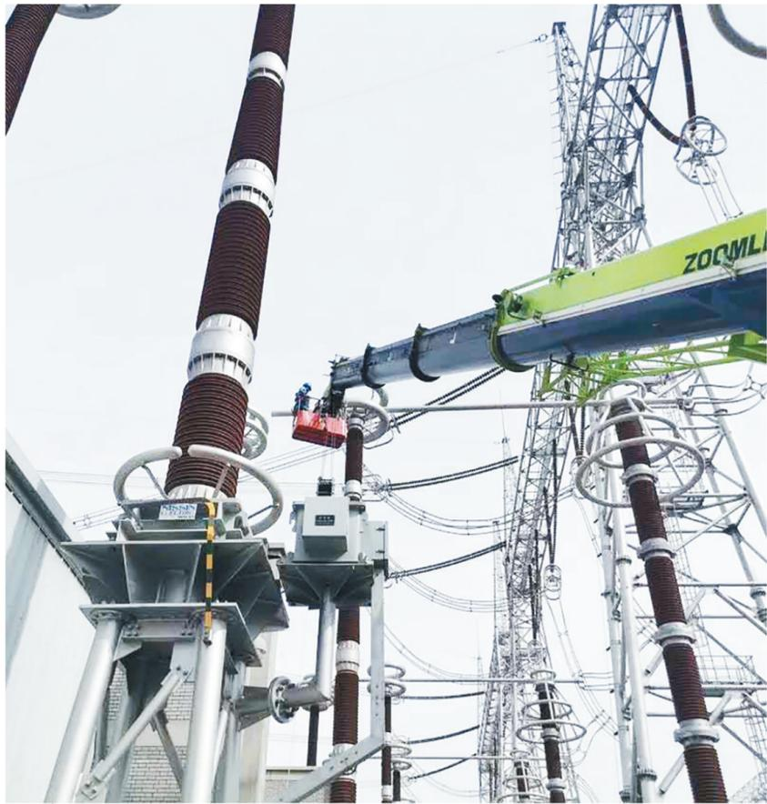
6月5日,陕西首座特高压站——1000千伏横山开关站年度综合检修工作正式启动。此次检修计划开展13天,检修设备173台,消缺40项,作业面11个,共7家单位约130余人参加检修。 □唐利 董文龙 摄
