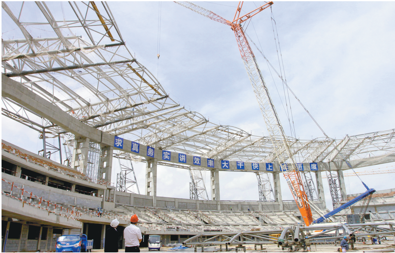
由陕建九建集团承建的省第十七届运动会主会场——榆林市体育中心项目,目前正在紧张施工,确保6月下旬钢结构全部完工。
