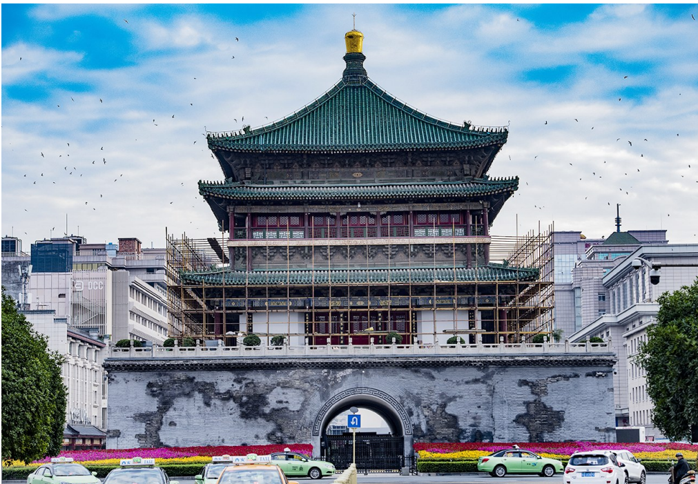
6月14日,工人搭建抢险加固修缮工程脚手架。 近日,西安市钟鼓楼博物馆在坚持“不改变文物原状、最少干预”的基本原则下,对钟楼宝顶、屋面、檐口、飞檐、外金柱进行闭馆修缮。修缮工作自6月10日至8月25日,共计75天。此次钟楼修缮,就是为了更好地保留历史信息,使钟楼文物本体能够得到更好保护,进而传承历史文化文脉。袁景智 摄
