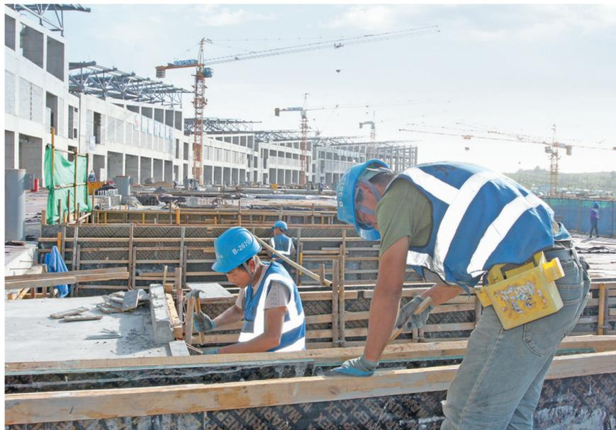
陕建九建集团承建的榆林市会展中心项目,占地450亩,由7栋建筑单体组成,建筑面积16.4万平方米,近日在完成钢结构屋架吊装后,正抓紧展厅二次结构和车库施工。项目部抢抓工期,加班加点,全力以赴将疫情影响的时间夺回来,实现节点目标。图为工人在进行车库楼梯的配模。
