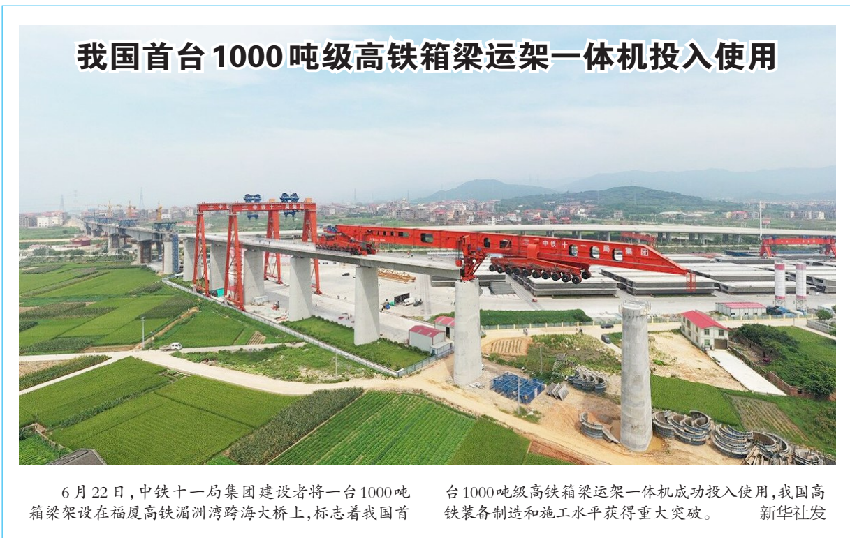
6月22日,中铁十一局集团建设者将一台1000吨箱梁架设在福厦高铁湄洲湾跨海大桥上,标志着我国首台1000吨级高铁箱梁运架一体机投入使用,我国高铁装备制造和施工水平获得重大突破。新华社发
