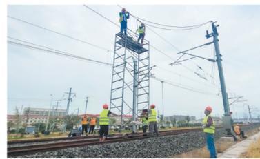
近日,在西安动车段内III区新建区域,中铁一局建安公司综合建设分公司对承建的高级修补短板工程进行冷热滑试验,并一次性获得成功。冷热滑试验是指列车在不带电和带电二种情况下进行的试验方式,是列车通车前必须进行的一项重要试验。
