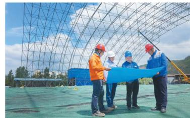
近年来,陕西华电瑞池发电有限公司着力改善企业生态化、生态产业化发展环境。图为项目建设单位及监理工程技术人员在建设环保型封闭式储煤场现场进行钢结构安装图纸核对工作。
