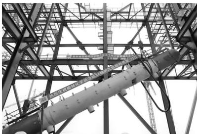
近日,榆林化学公司举行动力站3#锅炉汽包吊装仪式。吊装前,项目部进行了安全、质量及技术交底,并组织相关技术人员按照专项准备工作检查要求,对承重钢架螺栓紧固情况、吊装系统调试情况、起吊器具等进行了专项检查落实。此次3#锅炉汽包的顺利吊装,标志着动力站3#锅炉从土建、钢架吊装转入设备安装阶段。图为正在吊装设备。郭文静 摄
