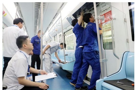
近日,地铁电客车客室门拆装比武在 1 号线西咸车辆段检修运用库开展,来自西安市轨道交通运营分公司车辆一部、车辆二部的 9 支代表队进行激烈角逐。图为参赛选手进行电客车车门故障处理。甘达 摄
