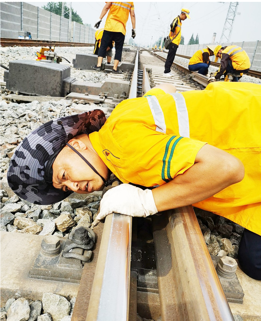
近日,中国铁路西安局集团有限公司汉中工务段分区段启动高温预警,采取添乘动态检查、地面静态检查动静相结合的方式,对管内设备进行全面检查,及时处置隐患,做好钢轨放热应急准备,为暑期运输安全打下坚实基础。 周俊英 摄
