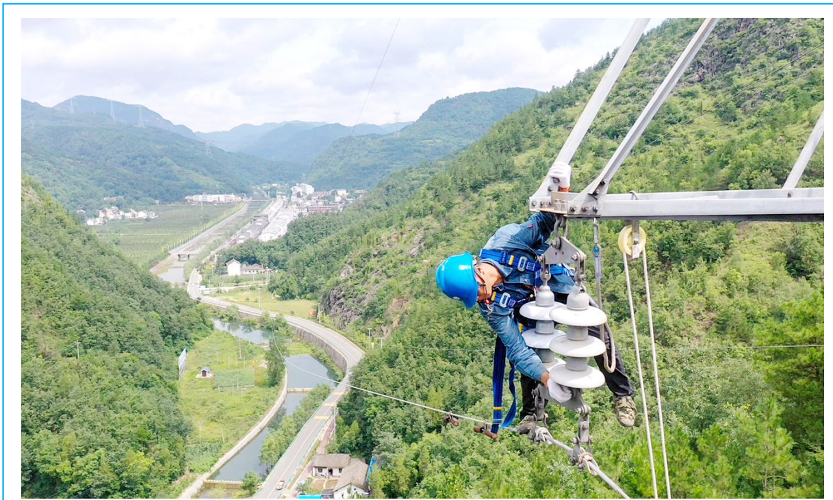
7月28日,国网商洛供电公司延长石油氟化硅厂专线、35千伏北宽坪变电站和东宽线进行停电检修改造。该公司通过发电车带电并网技术成功转接3条10千伏线路共71台配电变压器的供电负荷,顺利实现了检修期间对5385户居民的完全不间断供电,此举打破了检修需停电的传统壁垒,在商洛电网尚属首次。 祝赫 摄
