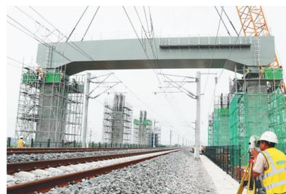
西关北城际铁路位于陕西关中盆地西北隅,全长约141公里,设计时速200公里,是陕西省“十三五”重点建设项目,也是陕西关中城市群城际铁路网的重要组成部分。近日,由中铁电气化局铁路工程公司承建的该铁路乾县右线特大桥跨西银高铁门式墩盖梁钢模板架设圆满完成。 倪树斌 摄
