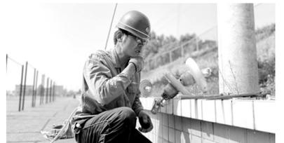
日前，韩城矿业配售电公司加大巡检力度，及早发现设备缺陷，及时进行消缺处理，避免因设备“中署”而影响电网安全运行。图为7月29日试验班班长仲维强正在下峪口矿立井变电站35千伏设备母线检修。 刘伟 陈晓瑜 摄
