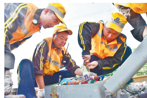
进入大暑节气后,中国铁路西安局集团有限公司西安电务段干部职工不惧高温,以道岔、轨道电路、电缆箱盒等设备为重点,积极投入设备专项整治工作中,确保暑期铁路行车设备运行安全。图为职工在更换转辙机。 □杨精松 摄
