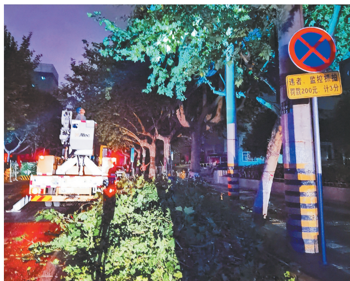
←近日,国网西安供电公司带电作业人员进行雨后紧急抢修。多日的强降雨给暑期供电造成不少安全隐患,该公司带电作业组为保障群众用电需求,本着“能带电、不停电”的服务承诺,力保长安电网平稳迎峰。杨浩 摄
