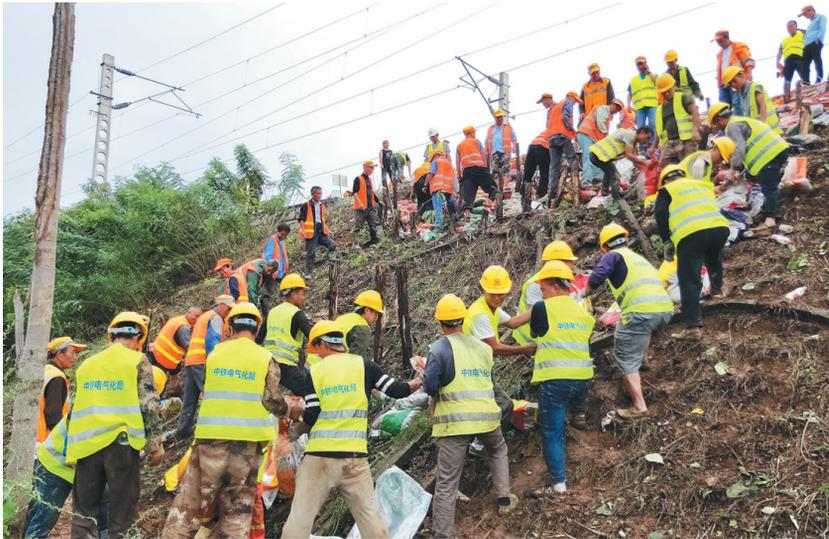
受连日降雨影响,8月16日,西(安)平(凉)铁路乾县段西区间路基边坡发生滑坡,影响行车安全。接到抢险通知后,中铁电气化局铁路工程公司立即组织抢险突击队,带着应急物资、抢险车辆和设备火速赶赴滑坡地段,冒雨对铁路路基边坡进行加固。经过连续6个小时奋力抢险,当日下午4时,加固工作全部完成。图为中铁电气化局铁路工程公司突击队正在对西平铁路抢险加固。倪树斌 赵明 秦发睿 摄
