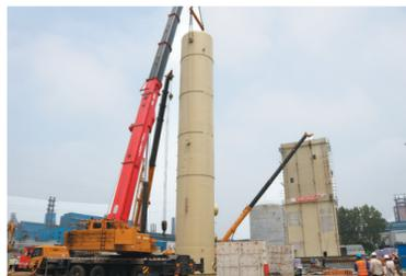
近日,陕建安装集团一公司徐州陕鼓6万+3万空分项目空冷塔、水冷塔吊装顺利完成。此次吊装大型设备4台,单台空冷塔重量超过40吨,高度超过25米,空冷、水冷塔的安装是本工程的关键施工节点,对尽早实现投产起到了推动作用。 □黄小龙 摄
