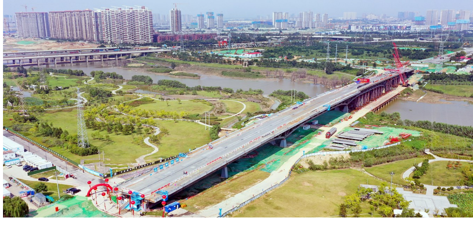
8月28日,位于西安市第十四届全运会沪渝核心区,由中建丝路投资建设的全国最大跨度连续钢桁梁桥、陕西第一座变高双层钢桁
