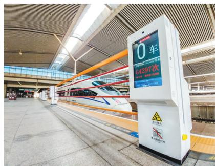
9月15日,西安北站9站台上的车站综合导控系统正在运行。该系统可根据列车到达与离开实现自动开闭,防止旅客随意跨越安全线进入股道,有效降低站台开放式结构的安全风险。 杨静龙 摄
