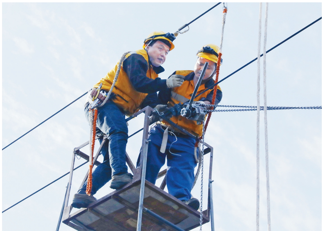
连日来,中国铁路西安局集团有限公司西安供电段针对铁路供电设备季节性变化特点,组织职工开展秋季设备检查整修。图为该段职工对陇海线树园至渭南区间下行接触网设备进行检修。 程如远 摄
