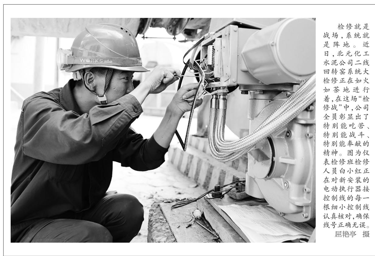
检修就是战场,系统就是阵地。近日,北元化工水泥公司二线回转窑系统大检修正在如火如荼地进行着,在这场“检修战”中,公司全员彰显出了特别能吃苦、特别能战斗、特别能奉献的精神。图为仪表检修班检修人员白小红正在对新安装的电动执行器接控制线的每一根细小控制线认真核对,确保线号正确无误。屈艳亭 摄
