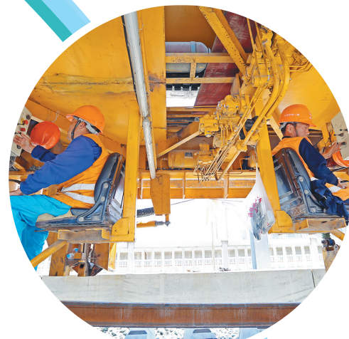
西银高速铁路
