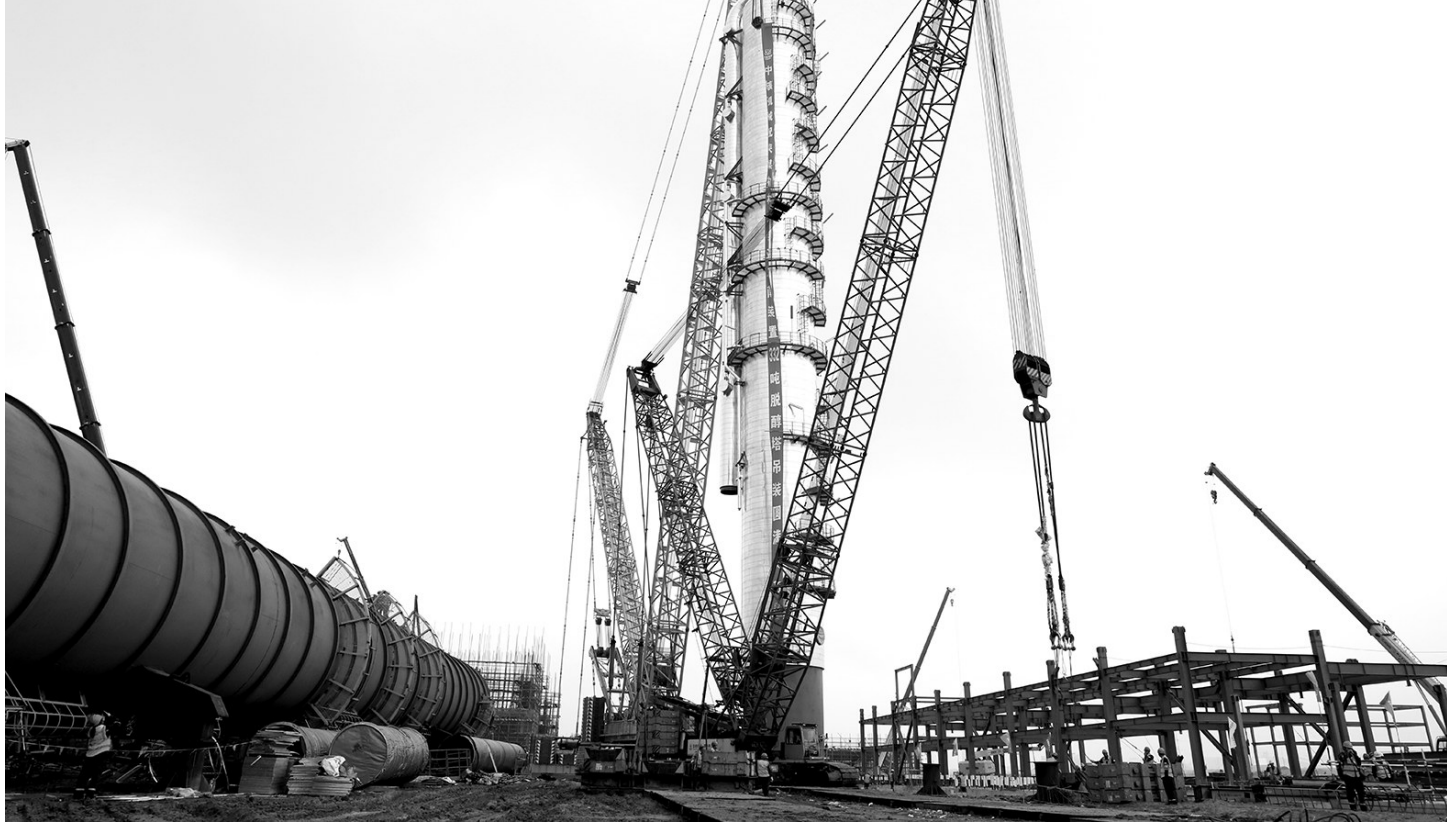
近日,榆林化学180万吨/年乙二醇项目EG装置核心设备脱醇塔吊装顺利完成。
