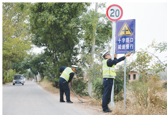
10月13日,渭南市澄城县公安局交通管理大队联合县交通局,在东环路代庄段、赵家庄段等地段,对道路交通安全隐患进行排查,着力解决制约农村道路交通安全的源头性和根本性问题。
