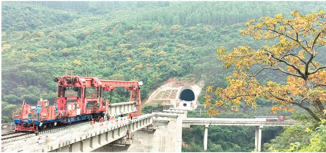
10月16日,中铁一局玉磨铁路铺架制梁项目部员工正在进行玉二塘玉元高速双桥跨玉磨高速公路架桥作业。该项目位于云南省元江县境内,全长445米,共有11跨。项目部员工积极响应公司开展的决战四季度倡议,昼夜奋战在工地上,铺架施工有序向前推进。 □刘顺良 摄
