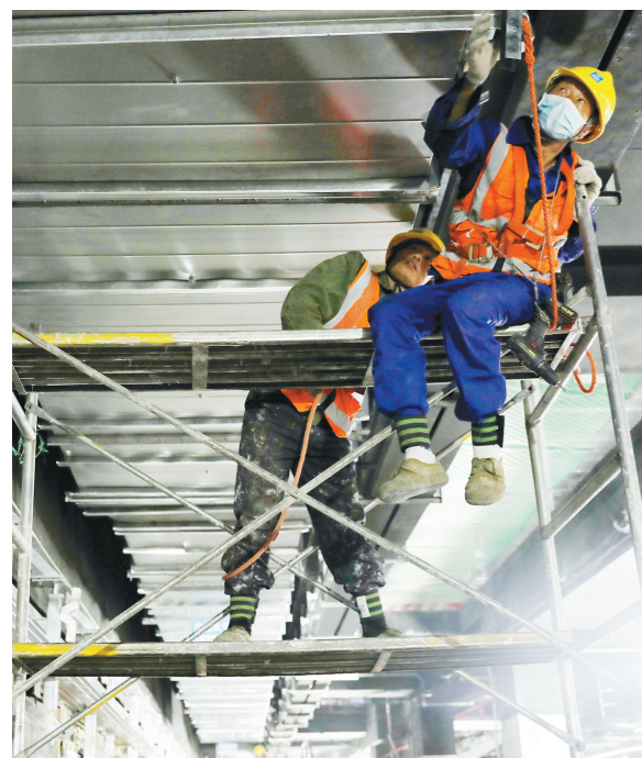
11月2日,由中建丝路建设的西安市地铁十四号线SGZCB-2标段,进入车站附属结构上建筑施工、站内安装装修同步施工阶段。 本报记者 刘强 摄
