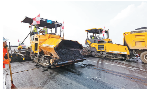
日前,郑州新郑国际机场三期扩建工程南飞行区场道改造工程项目已全部完工,陕建机股份生产制造的8台系列沥青混凝土摊铺机承担了全部项目摊铺施工任务,其中6台摊铺机联机并铺,经过十余天昼夜不间断连续施工,一次性完成该段主跑道施工,高质量顺利完成全部摊铺任务。张晋安 摄
