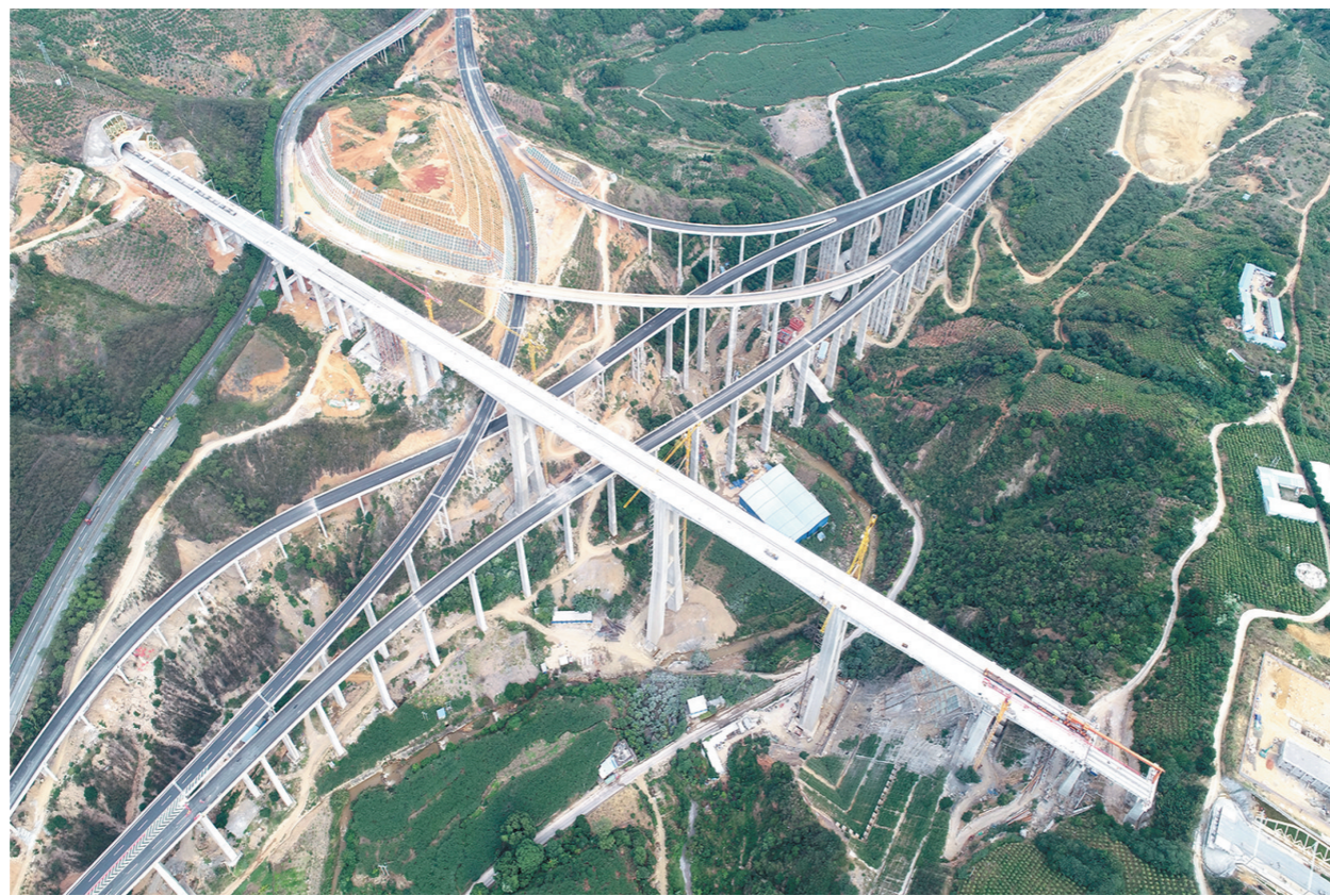
11月4日,中老铁路玉磨段完成南溪河四线特大桥架梁施工(航拍),至此,中铁一局玉磨项目部圆满完成标段内架梁总量的三分之二,为冲刺年度铺架施工任务奠定了坚实基础。中铁
