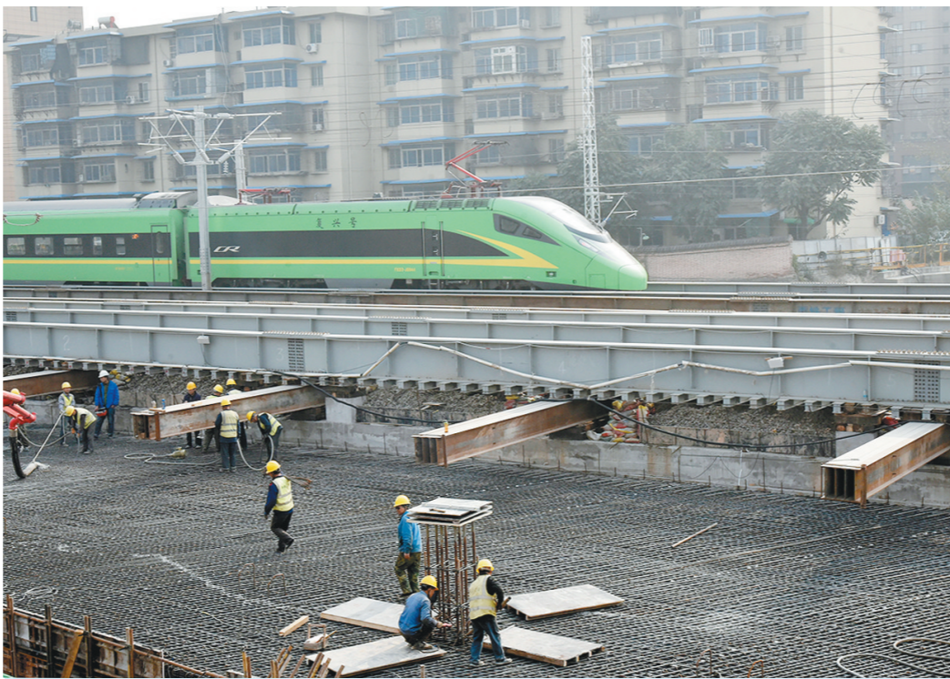
11月13日,一列复兴号动车通过施工工地。当日,西安市经九路下穿陇海铁路立交工程的瓶颈施工项目——6号箱涵顶板正式开始浇筑施工。据了解,该项目是打通经九
