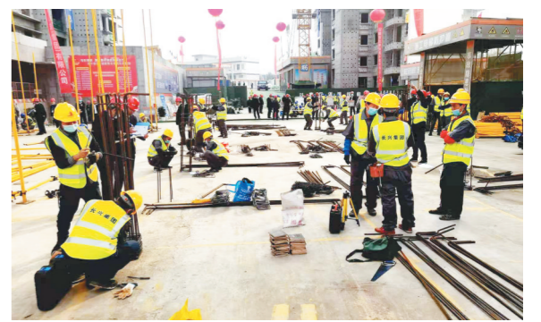
11月12日,由安康市总工会、安康市长兴建筑集团等主办的“长兴杯”建筑工人技能竞赛活动在天一城市之光项目部举行。此次比赛涉及砌筑工、钢筋工、木工、架子工、水电工五大工种,共有19支代表队参加。
