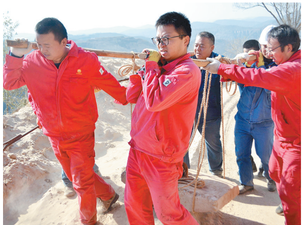
11月10日,在延安市志丹县杏河镇,长庆油田水电厂线路施工大队线路维护三队进行东云35kv23#拉线地锚消缺。图为队员们合力抬起约300斤重的地锚。
