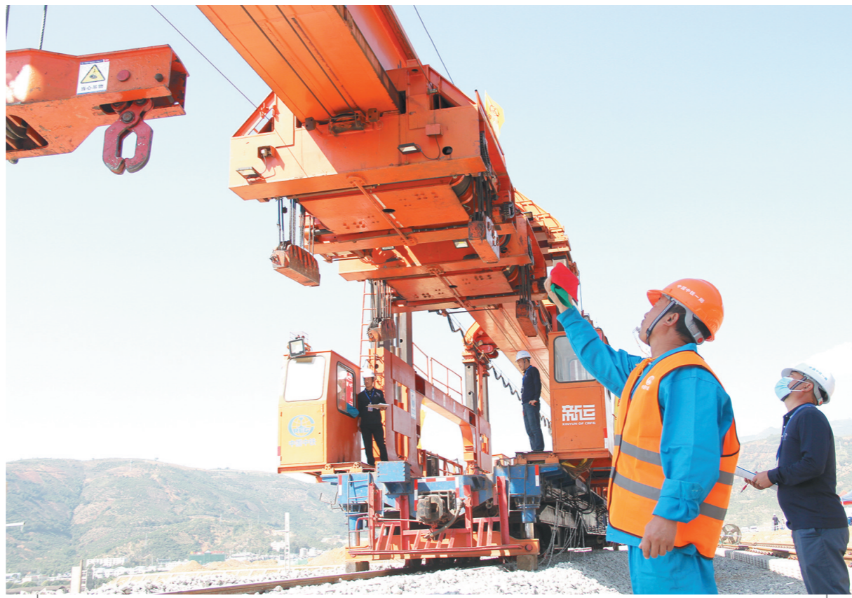
11月13日,经过两天赛场激烈竞争,2020年陕西省“中铁一局杯”铺架司机职业技能竞赛及中铁一局新运公司测量工职业技能竞赛,在云南元江县中老铁路建设
