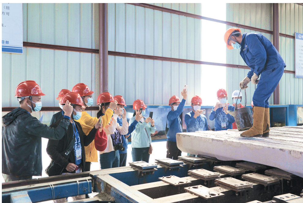
近日，在上海应用技术大学学习的6名老挝留学生，来到云南省玉溪市的中老昆万铁路国内玉磨段中铁一局玉磨铁路铺架制梁项目部观摩学习。图为留学生们参观轨排生产线上浇筑的硫磺砂浆锚固混凝土枕作业。
