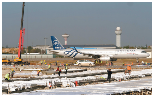
11月28日6时13分,MU9621西安—义乌航班从南跑道准点起飞,标志着西安咸阳国际机场三期扩建工程南飞行区第一阶段不停航施工完成,恢复至双跑道运行模式。
