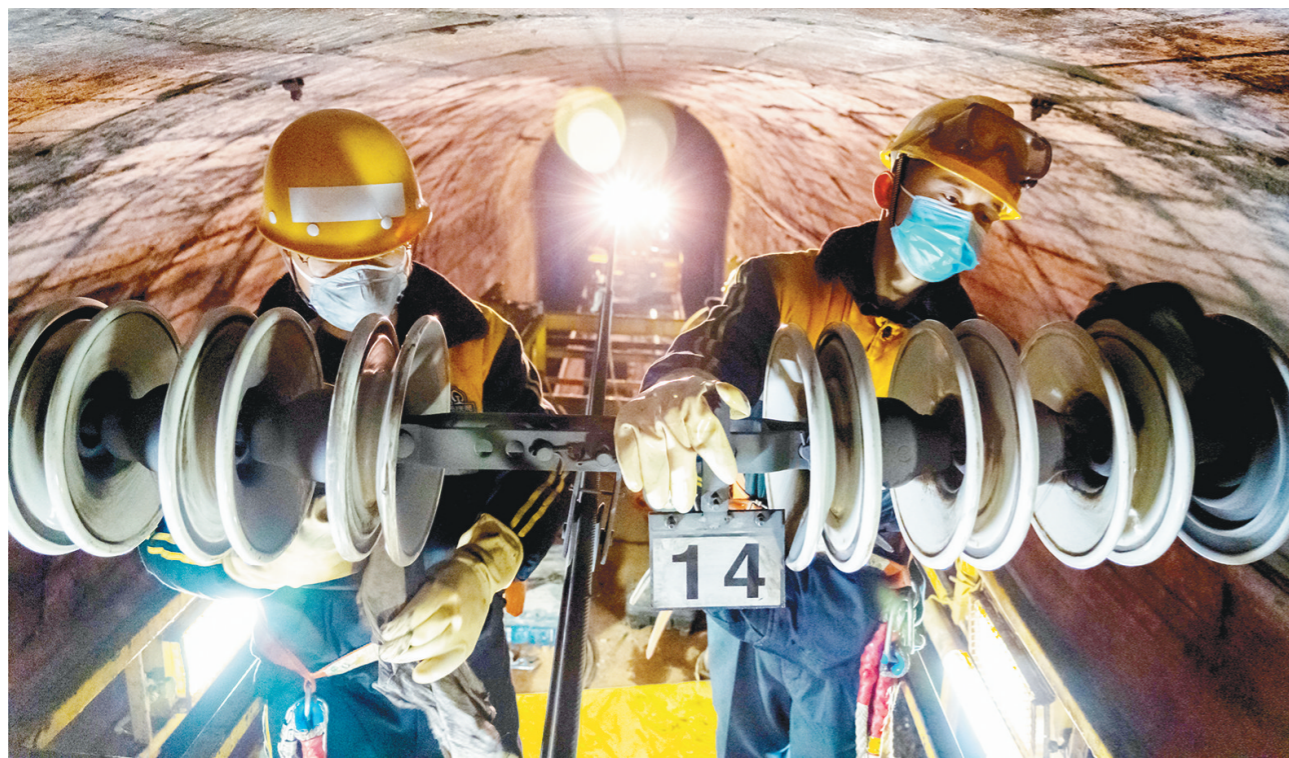
针对近期秦岭山区温度骤降,中国铁路西安局集团有限公司宝鸡供电段组织职工,对宝成铁路山区隧道内铁路供电设备进行巡检,重点检修关键处所设备状态,安
