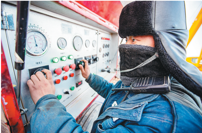
为了提高精确度,张力机操作手张昭昭卸掉手套进行操作。
