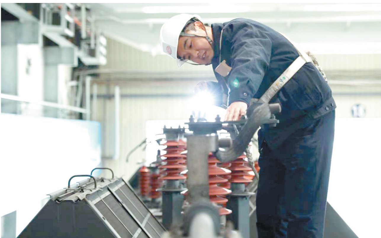
入冬以来,针对雨雪天气频发,中国铁路西安局集团有限公司安康机务段要求技术部门组织人员加强机车跟班作业比例,建立机车故障问题库,抽调专人对机
