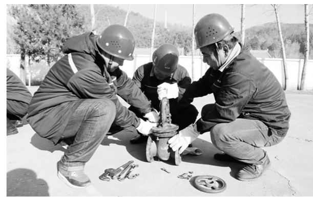
入冬以来,气温骤降,为防范各类安全事故发生,黄陵矿业机电公司结合当前安全生产实际情况,周密部署、细致安排,从“防”字入手,全面落实“冬季三防”各项工作,确保公司全年安全目标顺利完成。(朱建锋 摄)
