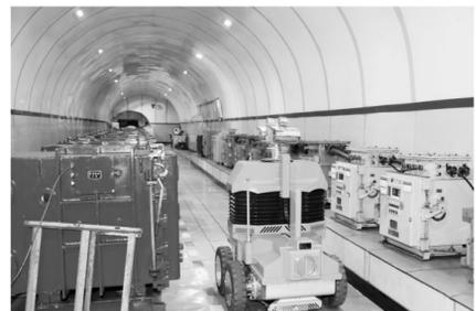
近日,铜川矿业玉华煤矿井下10千伏变电所迎来了巡检机器人,使设备巡检一步迈入智能化发展。图为机器人在巡检。朱建锋 摄
