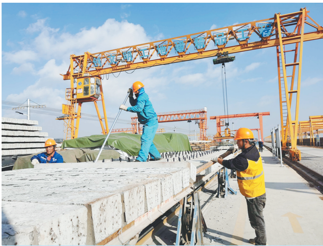
1月7日,中铁一局新运公司研和铺架基地施工现场一片火热。2021年是玉磨铁路的决胜年,项目部广大员工在工期紧、任务重、质量要求高的情况下,奋力拼搏,抓紧路料的储备为前方铺架架桥提供保障。图为员工在进行混凝土枕的卸车作业。 □刘顺良 摄
