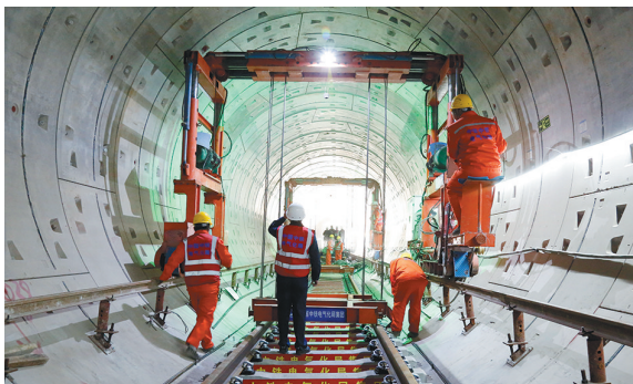
由中铁电气化局铁路工程公司承建的长沙市轨道交通6号线轨道工程近日进入铺轨阶段,这条地铁线路全长48.11公里。图为施工人员正在加紧进行铺轨作业。 □倪树斌 摄
